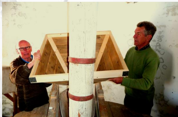
Henk en Ben plaatsen de "nieuwe kaar"
