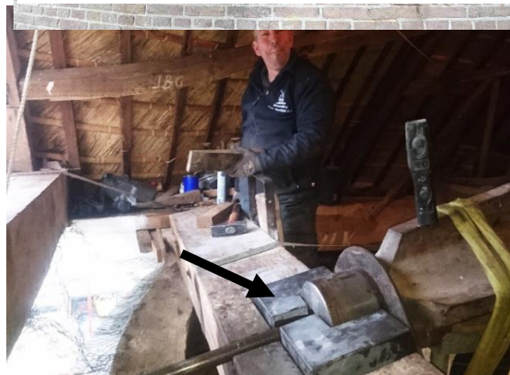
Molenbouwer bouwt nieuwe Pensteen in.
